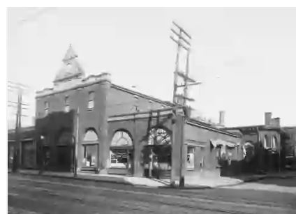
Marché Saint-Laurent (aujourd'hui démoli - 1180, boulevard Saint-...
