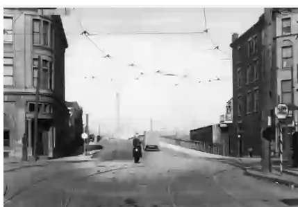
Pont ferroviaire de la rue de La Montagne
